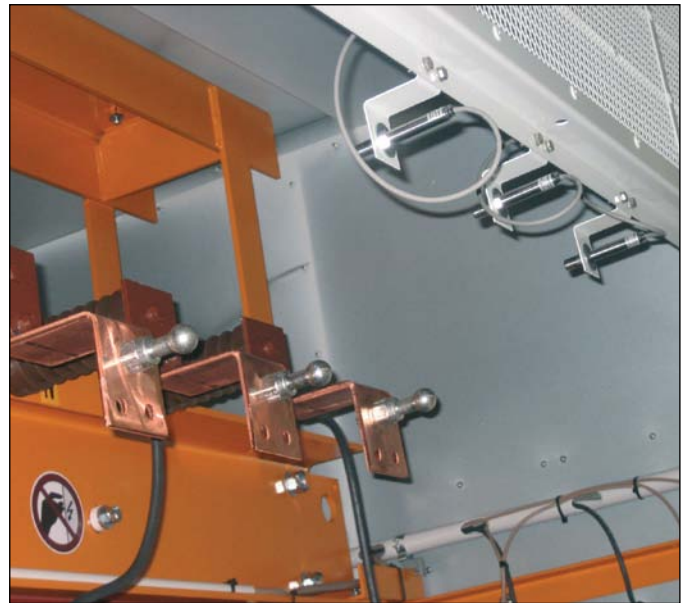
Abb. 4: Typische Messorte an Kontaktstellen
